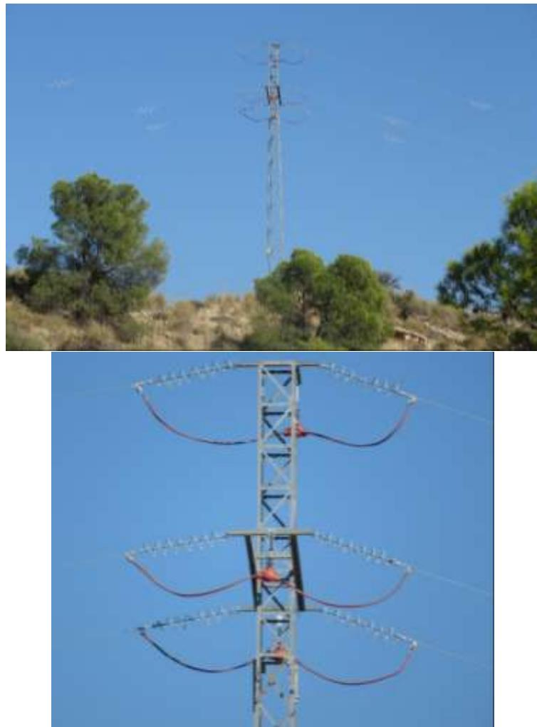
FOTOGRAFÍA 9 Y FOTOGRAFÍA 10. LÍNEA DE DERIVACIÓN DE LA PLANTA DE RESIDUOS. CUENTA CON PROTECCIONES ANTIELECTROCUCIÓN EN LOS PUENTES Y EN LAS CADENAS DE AMARRE, ASÍ COMO DISPOSITIVOS ANTI COLISIÓN EN LOS CONDUCTORES.
