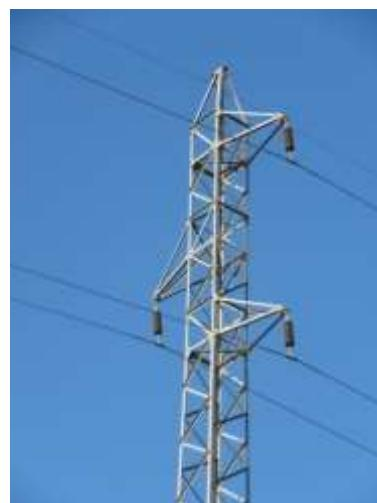
Fotografía 5, fotografía 6 y fotografía 7. Apoyo y trazado de la línea principal, ubicada al sur de la planta. Apoyo en alineación suspendido en tresbolillo. Detalle.
