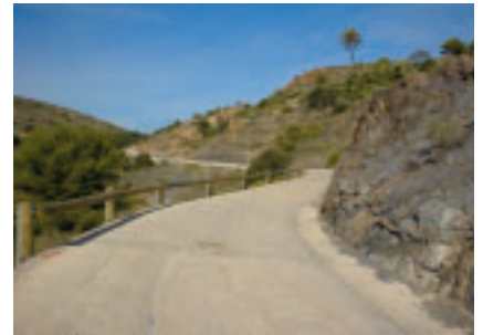
Quitamiedos en el camino de acceso al aparcamiento principal (G.L.G.)
