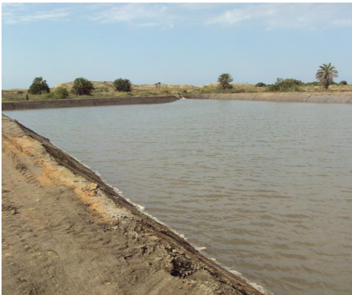
Fig. 3: Charca almacenadora impermeabilizada en El Rasall
