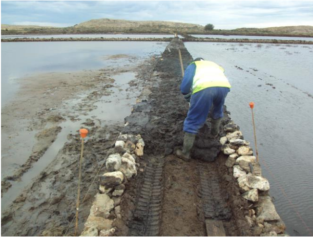
Fig. 5: Recuperación de motas en El Rasall con piedra seca y fangos
