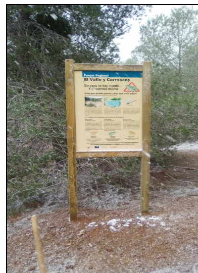
Imagen 7: Colocación de uno de los paneles informativos
