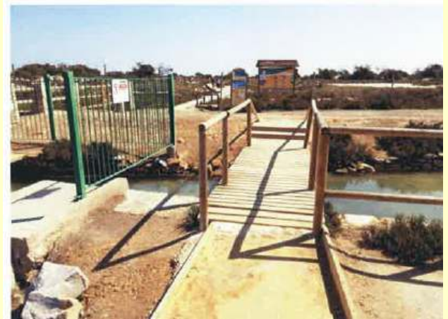
Tramo de escalones a eliminar para mejorar la accesibilidad en el cruce del Sendero de las Encañizadas y el del Coterillo en la Curva de la Culebra
