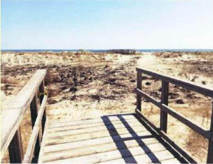
Tramo de pasarela afectada por incendio que será reconstruido
