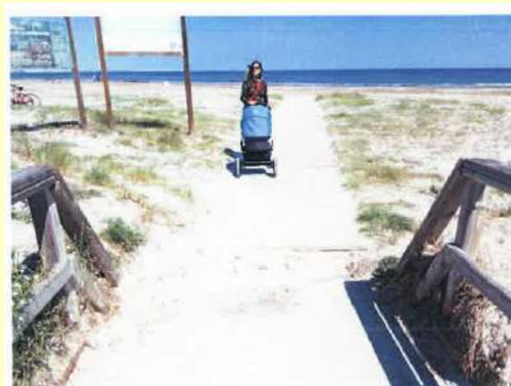
Escalón a eliminar para mejorar la en pasarela de llegada a playa de la Torre Derribada desde aparcamiento de Coterillo
