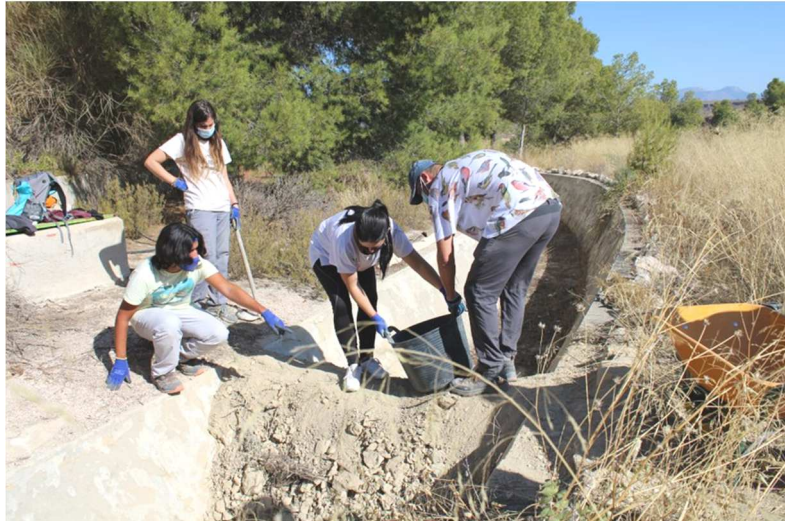
Figura 2. Construcción de una rampa de tierra en el Canal abandonado del Luchena en el marco de una actuación de voluntariado para la conservación de la tortuga mora. Fotografía: Naturactúa.
