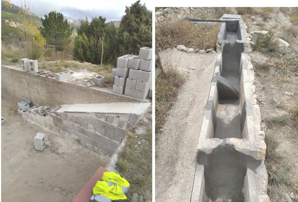
Figura 4. El Servicio de Planificación, Áreas Protegidas y Defensa del Medio Natural de la CARM, con el asesoramiento de este PSB, ha construido sendas rampas para facilitar la salida de anfibios en dos balsas de extinción de incendios. Además ha construido un abrevadero y reparado otro existente. Fotografías cortesía de Carlos Cuadrado y Enrique Acosta.
