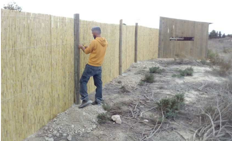
Foto 3: Voluntario trabajando en la instalación de la pantalla
